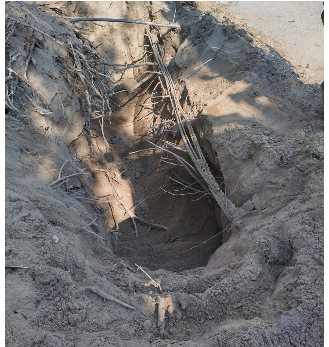
Kuva 2. Raskaiden polttoöljysäiliöiden alue. Koekuoppa 2. Koekuopan syvyys on n. 2,7 m.
