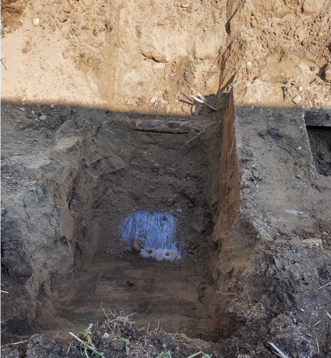
Kuva 1. Raskaiden polttoöljysäiliöiden alue. Koekuoppa 1. Koekuopan syvyys on n. 2,4 m.
